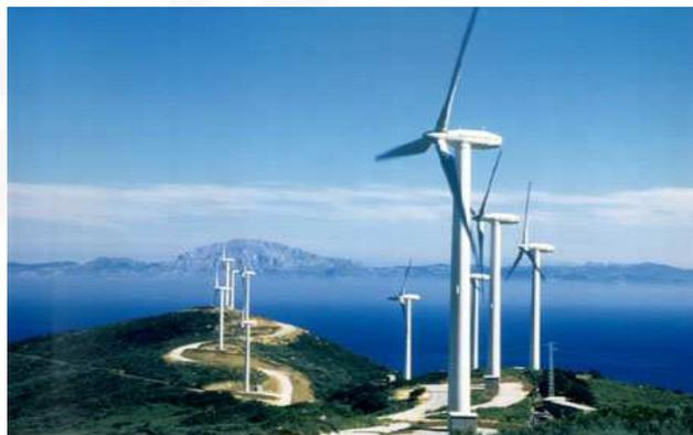
O vento forte pode rodar as lâminas de uma turbina adaptada para o vento (em vez do vapor ou da água é o vento que faz girar a turbina). A ventoinha da turbina está ligada a um eixo central que contém em cima um fuso rotativo. Este eixo chega até uma caixa de transmissão onde a velocidade de rotação é aumentada. O gerador ligado ao transmissor produz energia elétrica.
